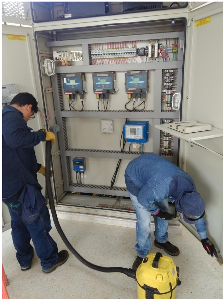
Figura 9. Limpieza del tablero con aspiradora y brocha.
